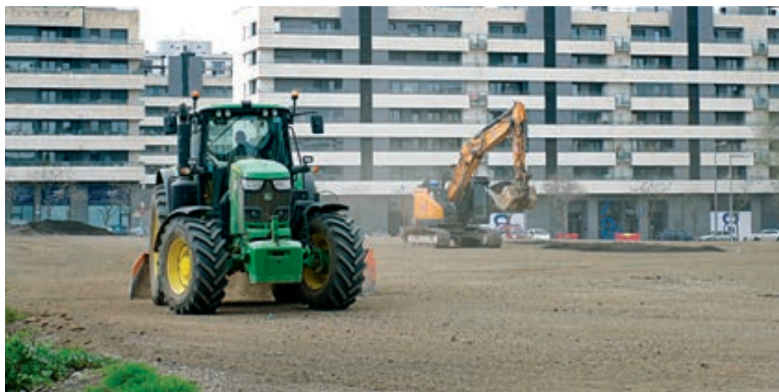
FOTO_ Núria García Un tractor aplanar la terra abocada per una màquina a l'aparcament
