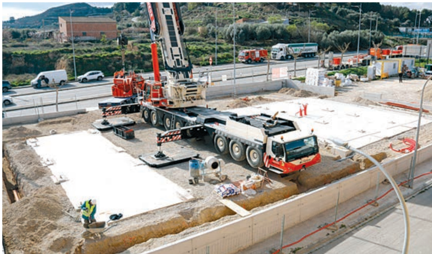
FOTO_ACN Terreny on s'ubicarà el nou parc de Bombers de Seròs abans de la instal·lació dels mòduls prefabricats
