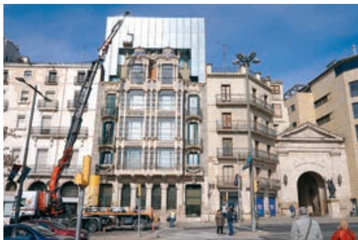
FOTO_ Jorge Agustín Una gran grua porta material a la coberta del Pal·las, a la banda de l'avinguda de Blondel
