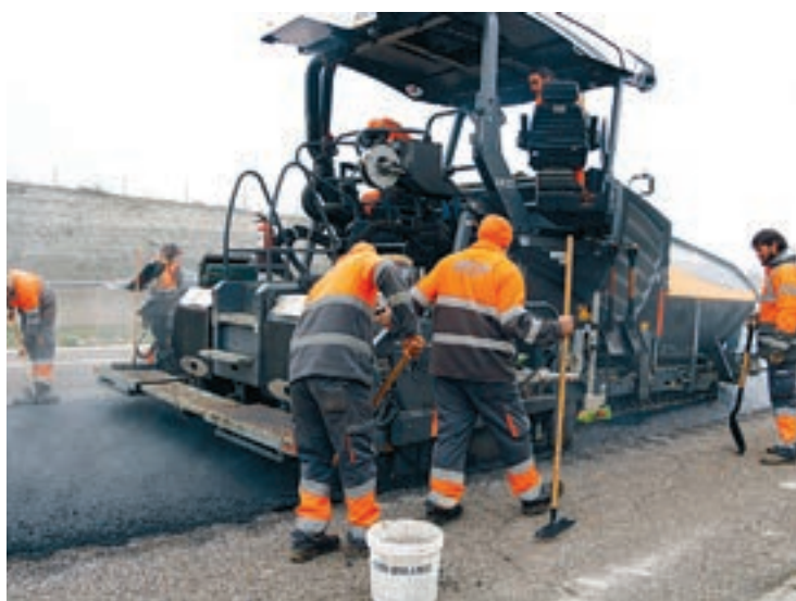
FOTO_ACN Diversos operaris treballant en la calçada
