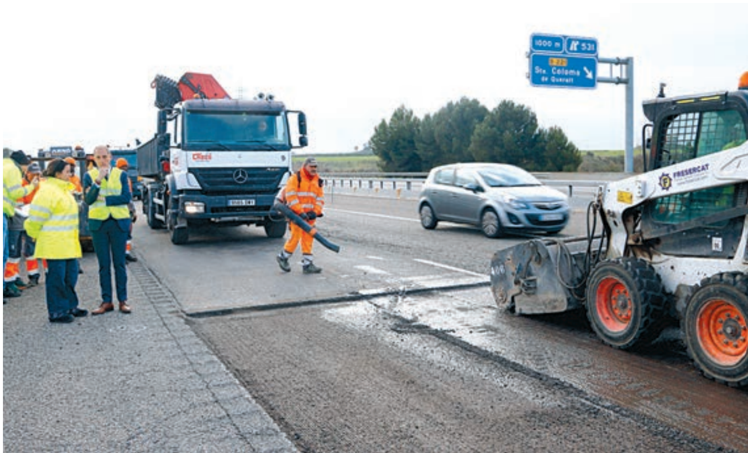
FOTO_ACN Crespín va visitar ahir les obres de millora del ferm de l'autovia entre Cervera i Ribera d'Ondara
