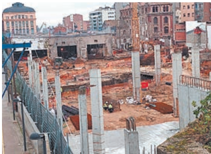
FOTO_ Tony Alcántara Eleven els pilars del baixador
