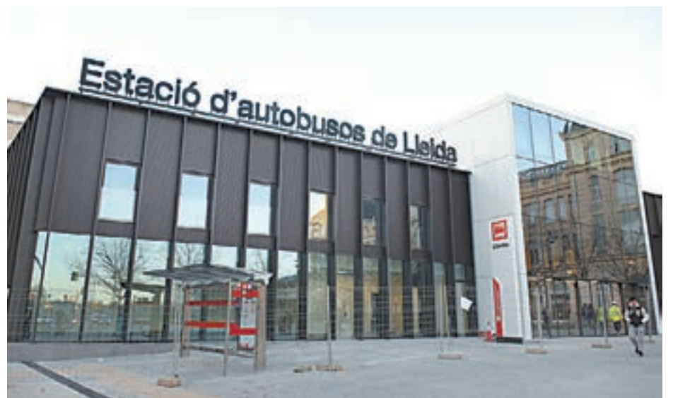
FOTO_ Núria García L'accés a l'estació ja finalitzat amb les tanques
