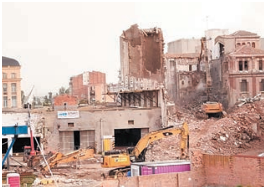
FOTO_ D.A. Demolició de les sitges de l'antiga Meta
