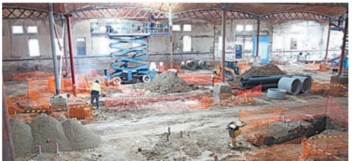
FOTO_ Tony Alcántara L'interior dels Docs durant les primeres obres d'aplanament
