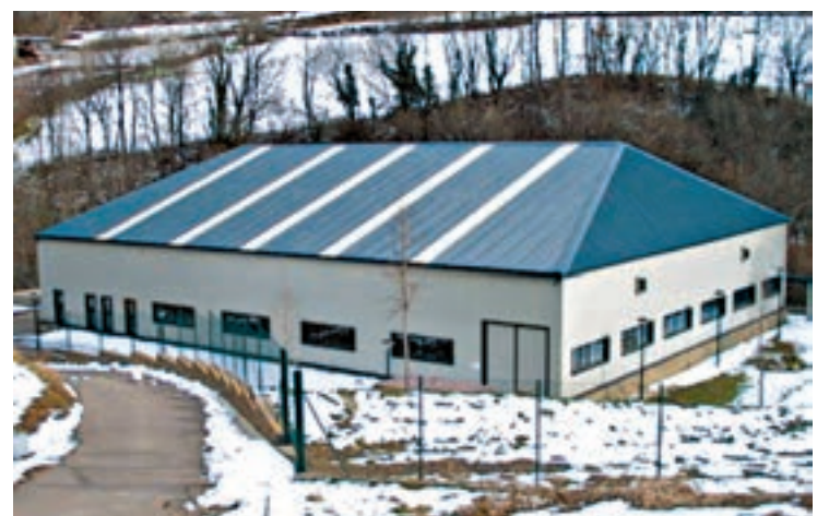
FOTO_ Agència Catalana de l'Aigua Vista general de la depuradora de Boí, situada a l'Alta Ribagorça
