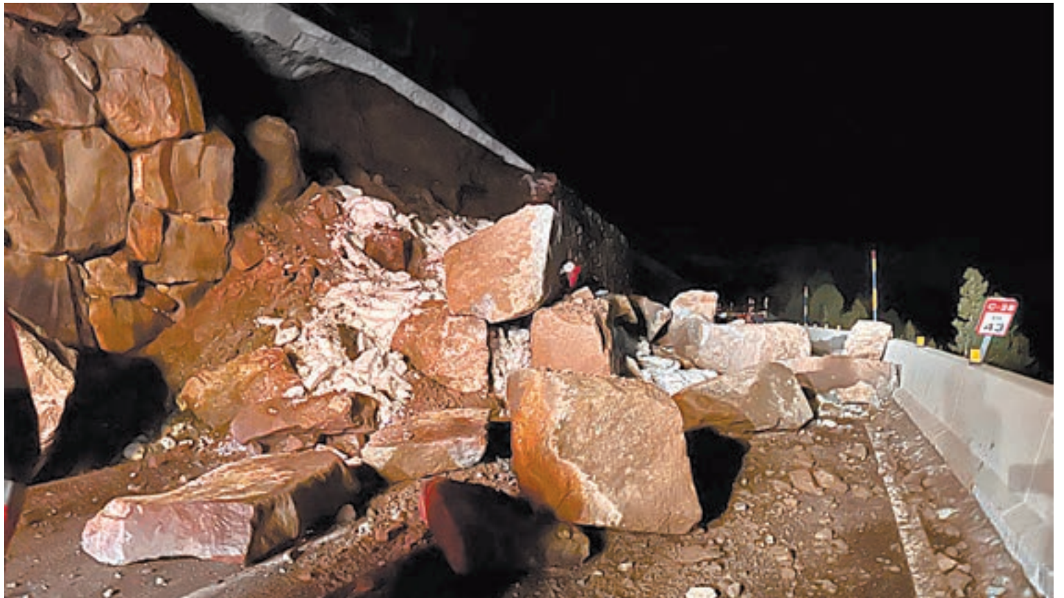
FOTO_L.M. L'escullera de la C-28 que ha cedit ha envaït de pedres de grans dimensions la carretera
