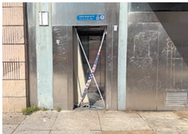
FOTO_ L.M. L'ascensor està avariat de nou
