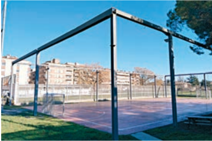
FOTO_ L.M. Imatge de l'estructura de l'antiga coberta
