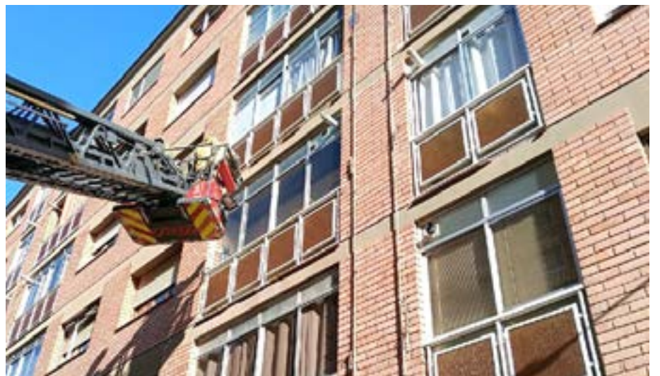
FOTO_ Bombers Els Bombers sanegen la façana de l'edifici
