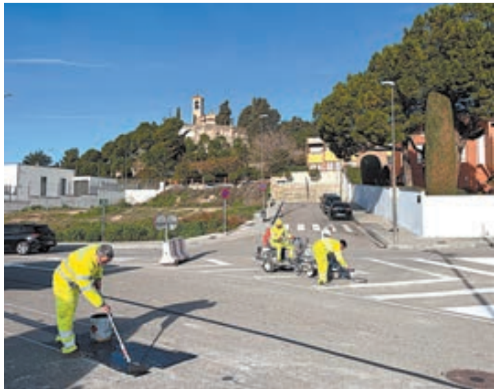
FOTO_ Aj. Tàrrrega Operaris treballant als carrers
