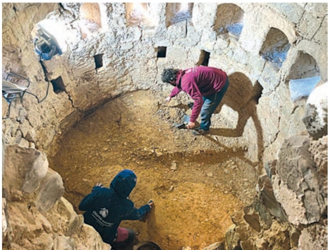
FOTO_ Aj. Tàrrrega Tasques d'excavació en un dels torricons que s'estan restaurant
