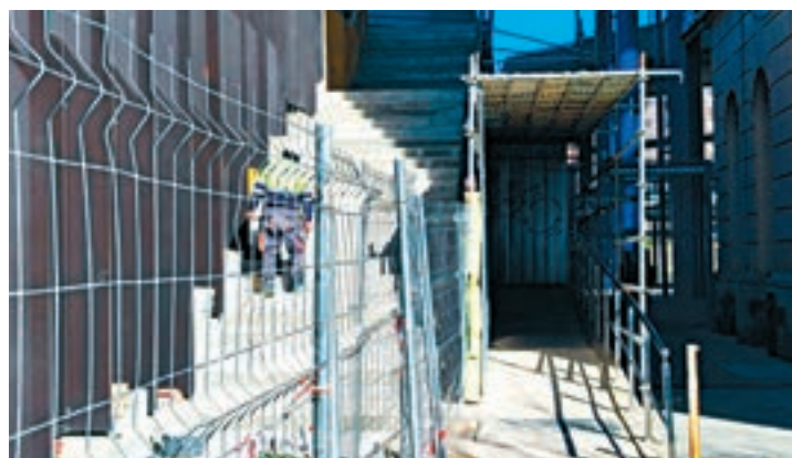
FOTO_ L.M. Operaris treballen a les noves escales
