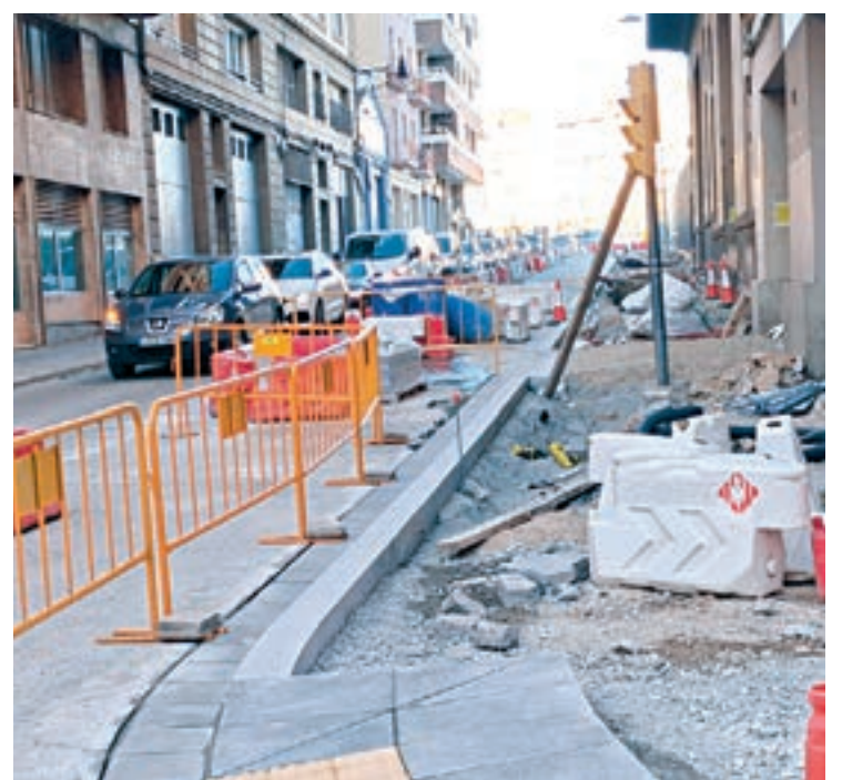
FOTO_ D.A. Estat de les obres a Comtes d'Urgell
