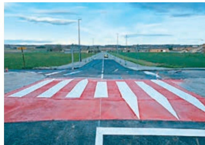
Aj. Torregrossa Pas de vianats i resalt a la Ronda Nord
