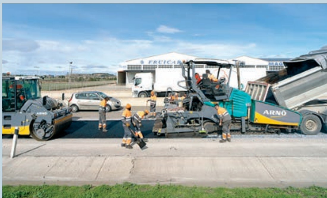
FOTO_Jorge Agustín Operaris treballant en la millora del ferm de la carretera
