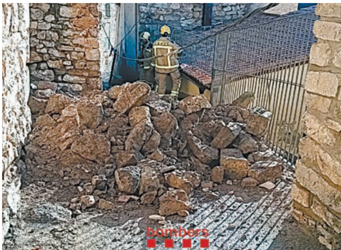
FOTO_Bombers Despreniment d'un mur a Estaràs a causa del fort vent
