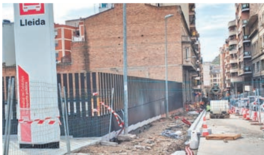
FOTO_ D.A. Treballs d'ampliació de la vorera del carrer
