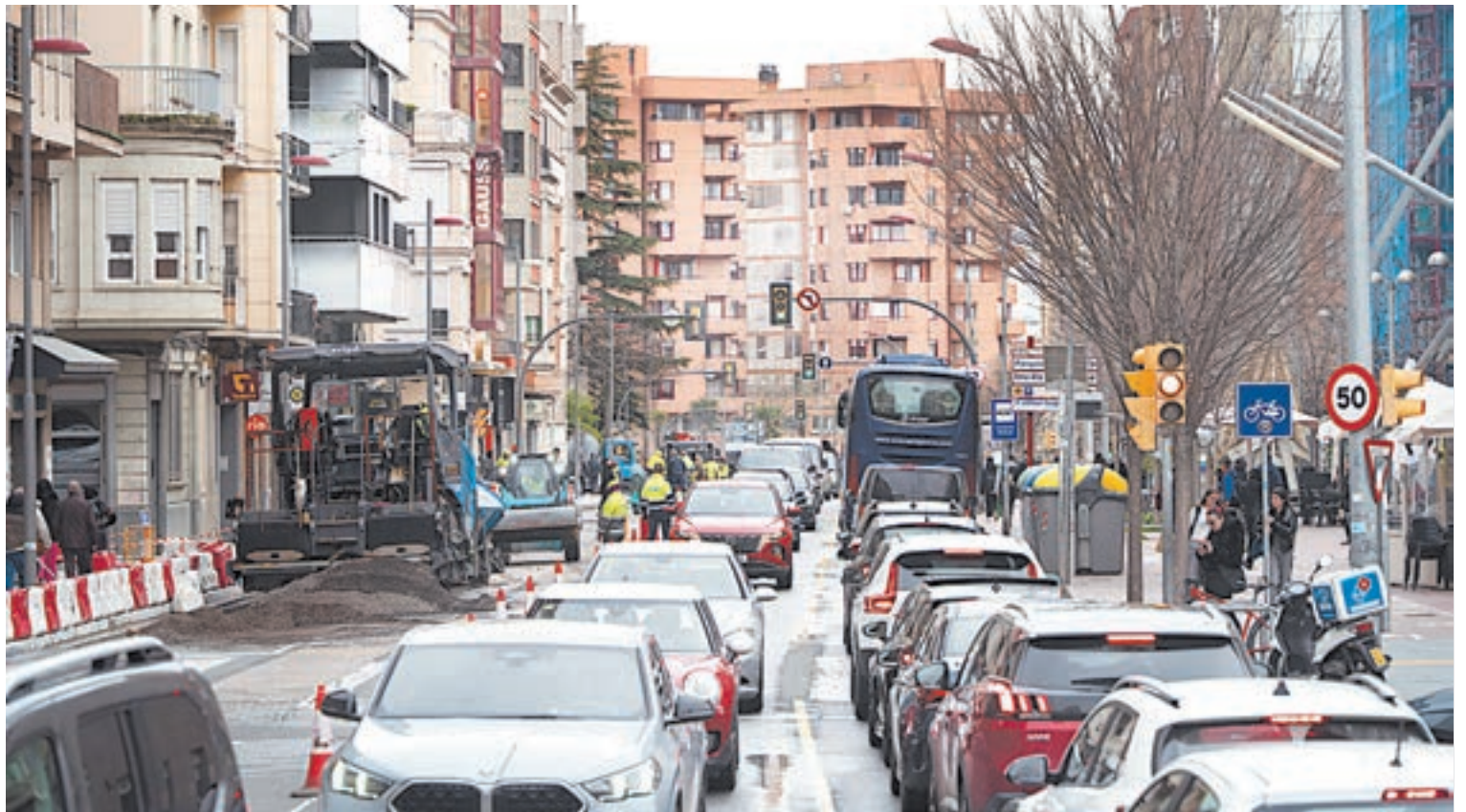
FOTO_ Jorge Agustín Cues de vehicles a l'avinguda de Balma per les obres de renovació de la calçada
