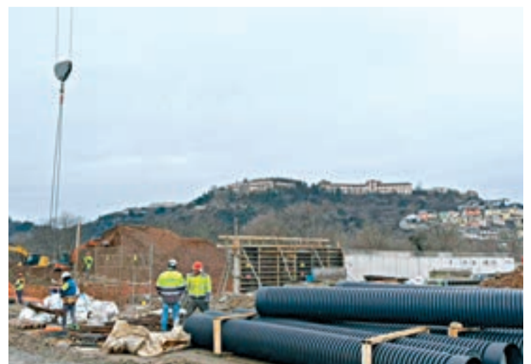
FOTO_Aj. Seu d'Urgell Operaris treballant a la zona
