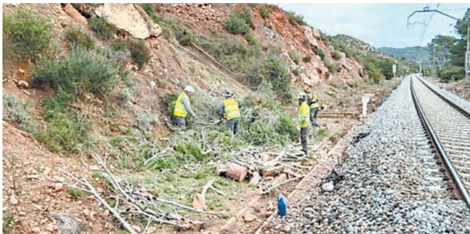
FOTO_ Cedida per Adif Els treballs de condicionament al tram de via de Picamoixons a Reus, aquest diumenge
