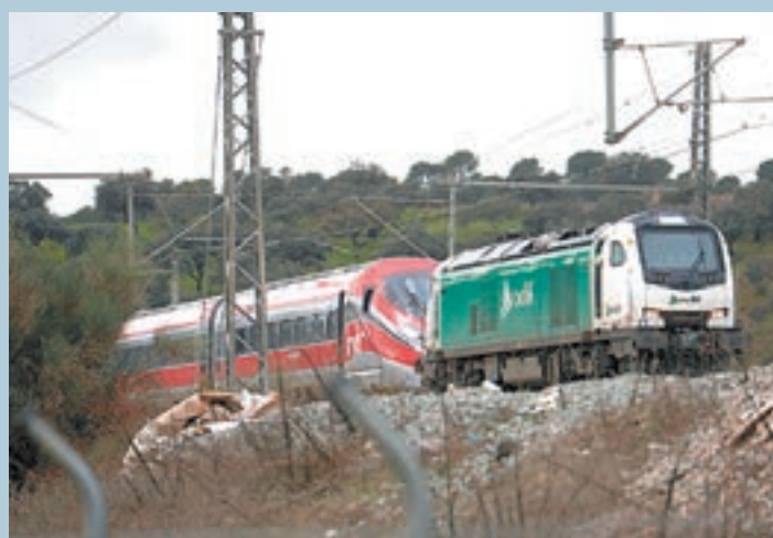
FOTO_ Salas (EFE) Treballs de retirada de les vies dels vagons del tren Iryo després de l'accident d'Adamuz
