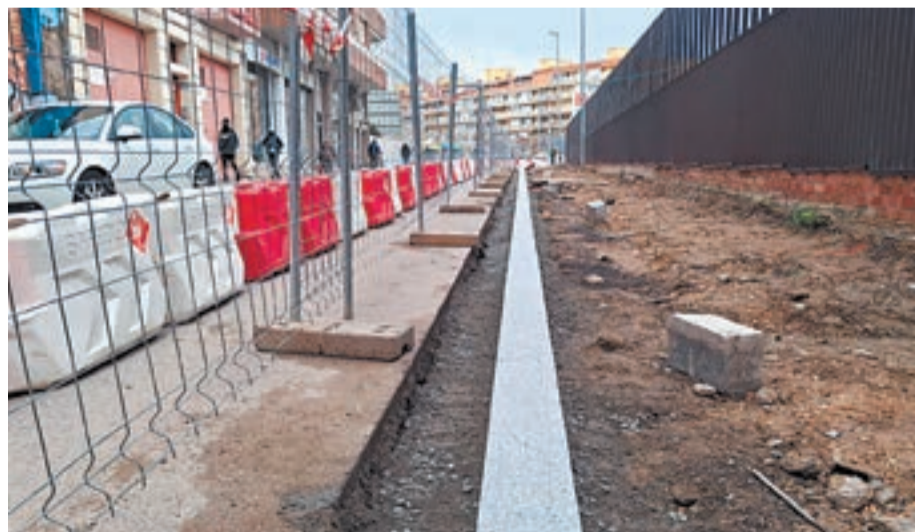
FOTO_ D.A. Imatge de la nova vorada, que permet ampliar la vorera
