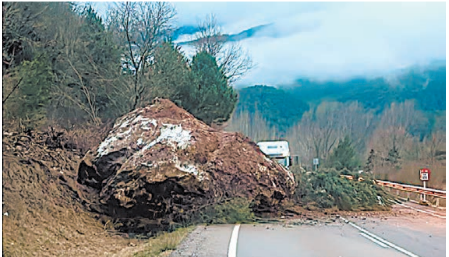
FOTO_Ajuntament d'Organyà Roques de grans dimensions caigudes a la carretera C-14 als Hostalets de Tost
