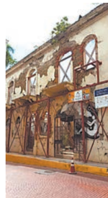
Casa del Barri antic, en reconstrucció
