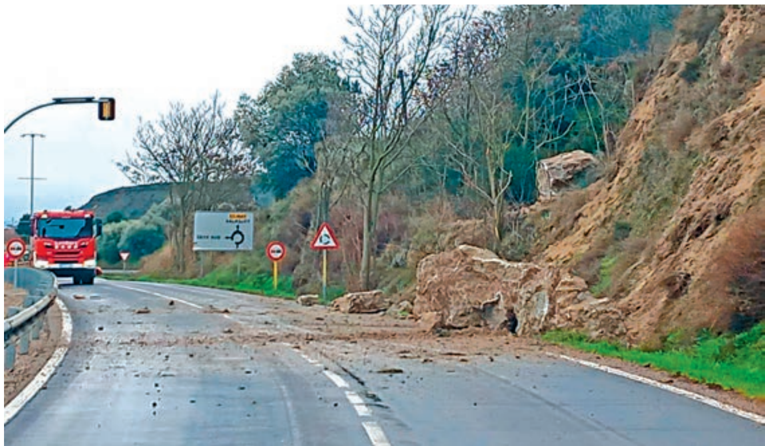
FOTO_L.M. Despreniment de terra i roques a la carretera LV-9047 a Gerb a causa de la pluja
