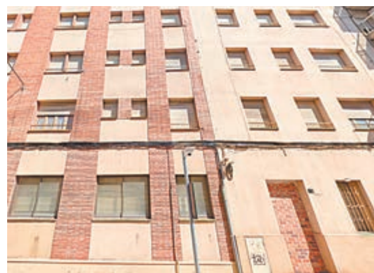
FOTO_L.M. Imatge actual del convent de les Josefines
