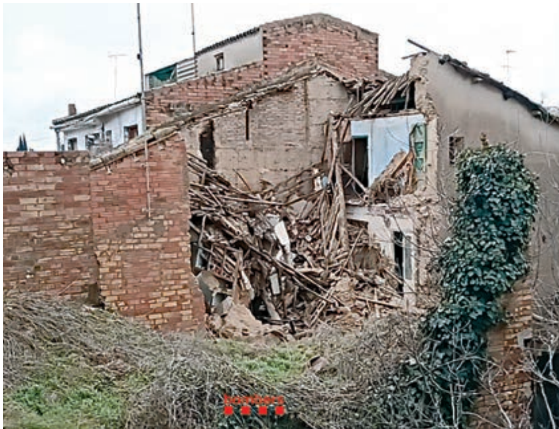
FOTO_ Bombers Imatge de la casa que va caure parcialment a causa de la pluja
