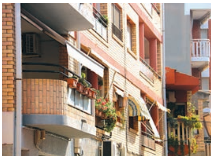
FOTO_ ACN Habitatges a la Granja d'Escarp
