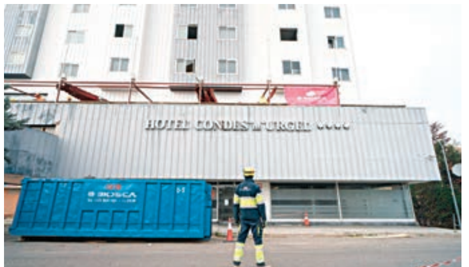
FOTO_ Jorge Agustín Treballs de buidatge de l'interior del vell hotel
