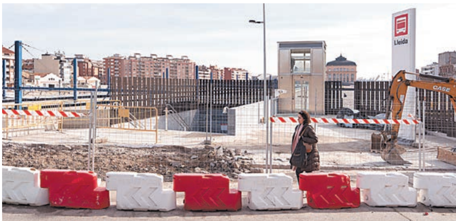
FOTO_ Jorge Agustín Obres al carrer Comtes d'Urgell, on s'eliminarà un carril i s'ampliaran les voreres
