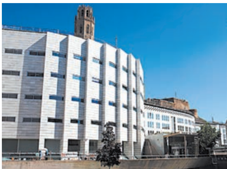
L'edifici judicial de Lleida al carrer del Canyeret
