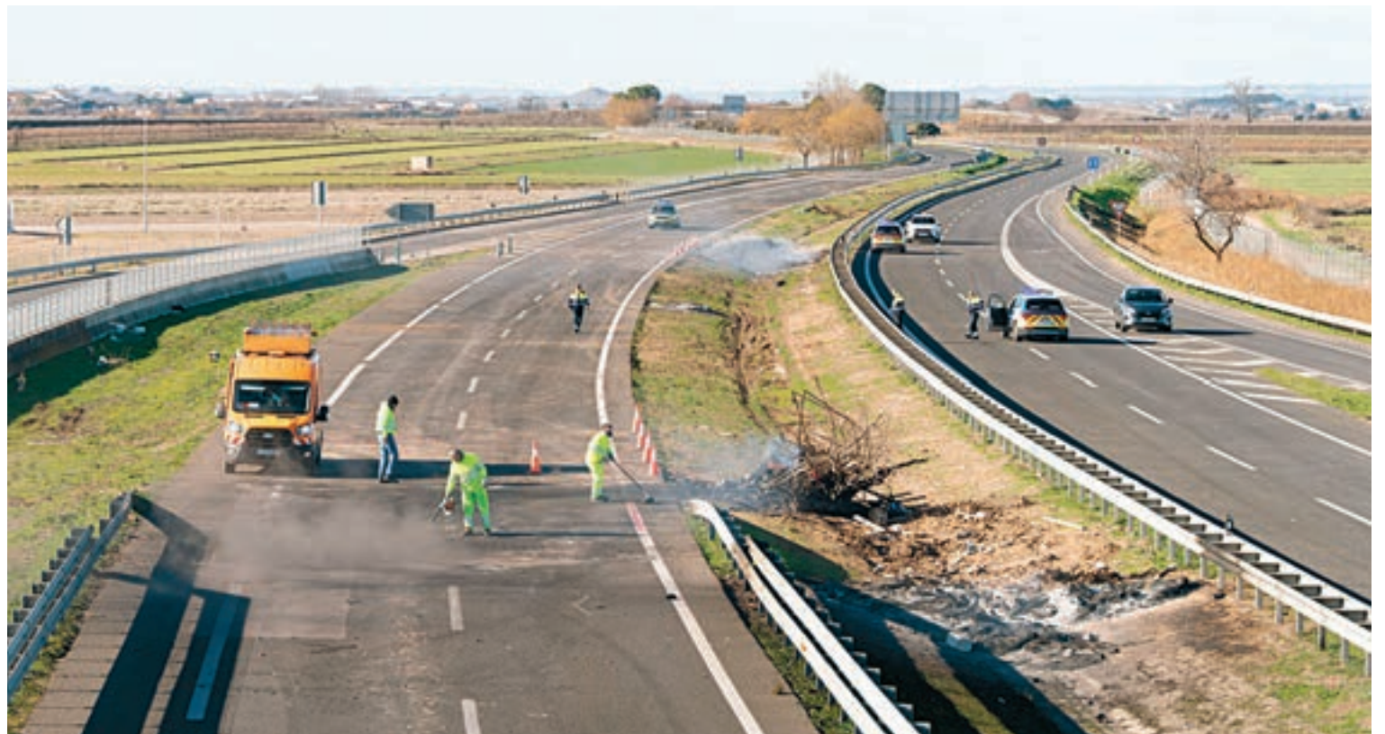
FOTO_ Jorge Agustín Els serveis de neteja treballen per posar a punt l'autovia per a la reobertura de la circulació
