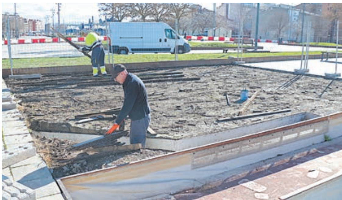
FOTO_ Núria García A dalt, zona renovada i, a sota, treballs per treure la fusta
