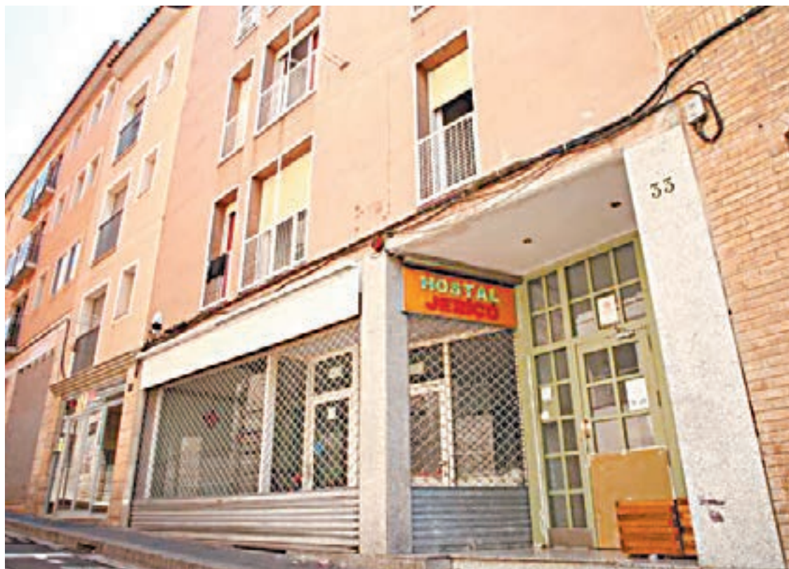
FOTO_ L.M. Imatge de la façana de l'hostal de la Fundació Jericó, al carrer Tallada
