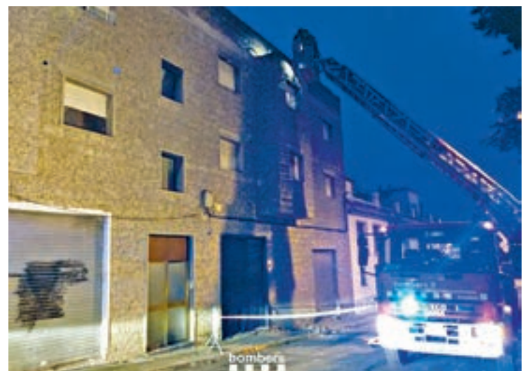
FOTO_ Bombers de la Generalitat Els Bombers van retirar els elements de la façana a punt de caure
