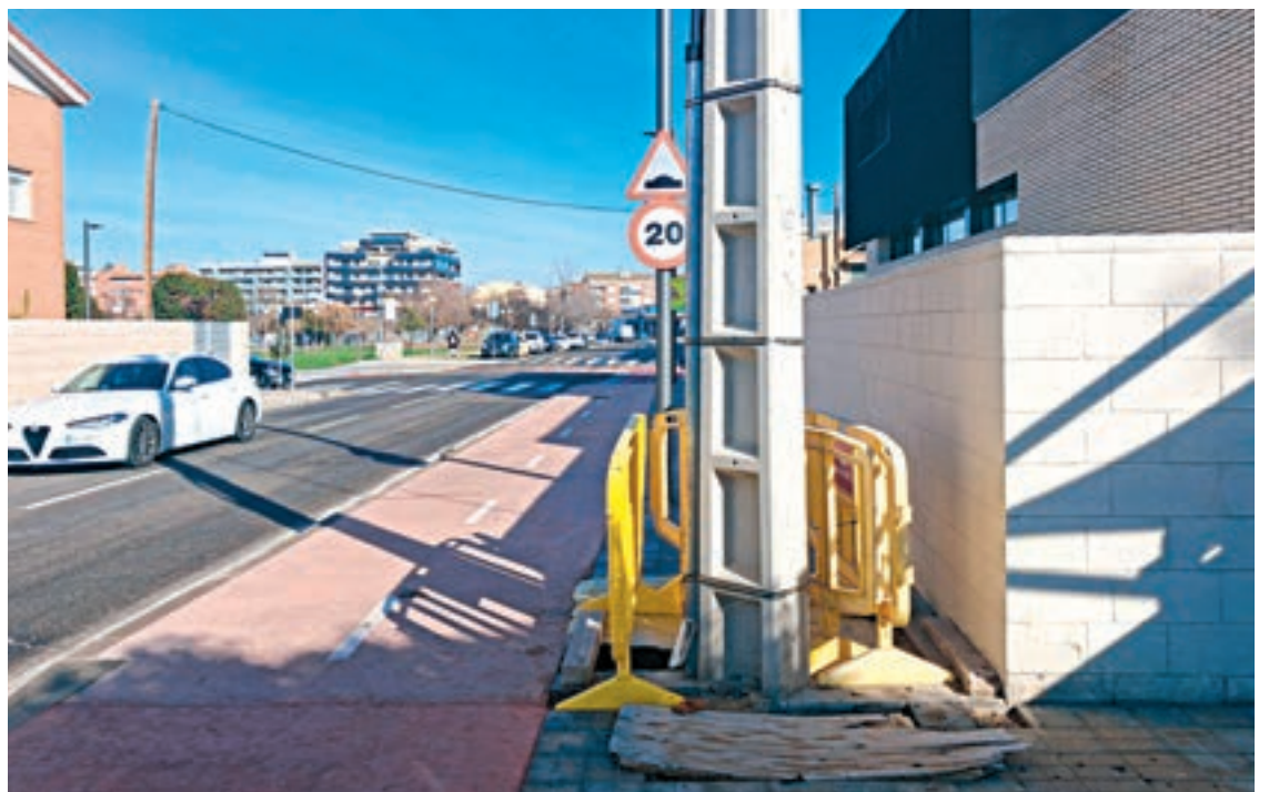
FOTO_D.A. El pal de la llum, de formigó i envoltat de tanques d'obra, obliga els vianants a passar pel carril bici
