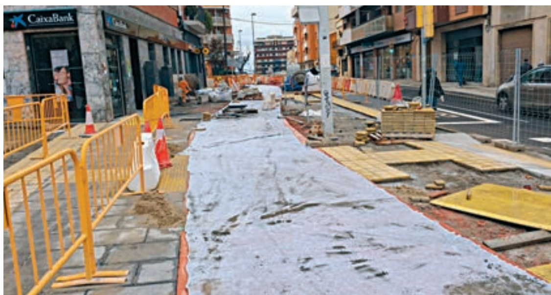
FOTO_ D.A. Imatge de les obres de l’avinguda de Flix, que encara estan en marxa
