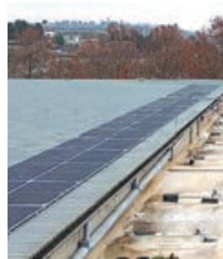
FOTO_ Aj. Tàrraga La coberta també s'ha impermeabilitzat
