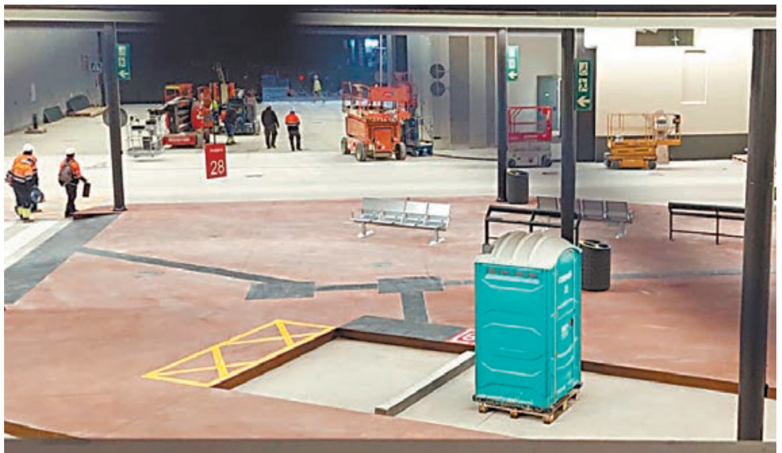
FOTO_Tony Alcántara Estat actual de les obres a l'interior de la zona de les andanes de la nova estació de busos
