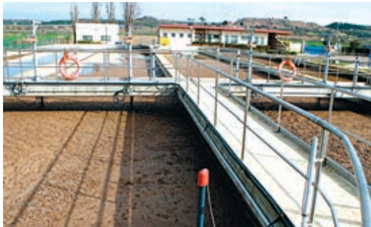
FOTO_ Ajuntament Tàrrega Instal·lacions de l'estació depuradora d'aigües residuals de Tàrrega
