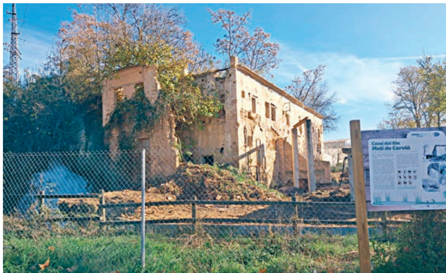
FOTO_D.A. Un dels edificis del Molí de Cervià, ara ben visible després de desbrossar la vegetació
