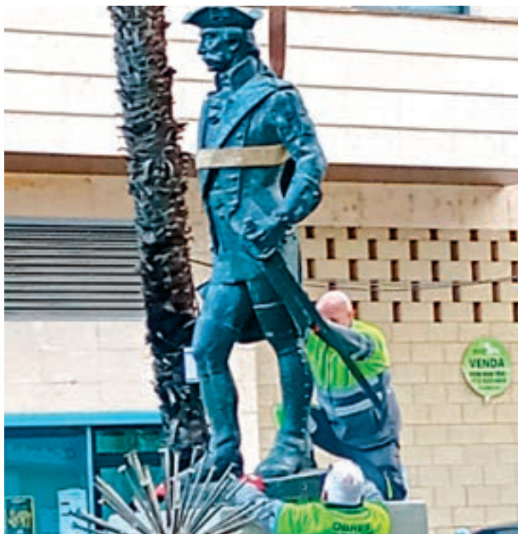
FOTO_Paeria Operaris de la brigada durant la instal·lació
