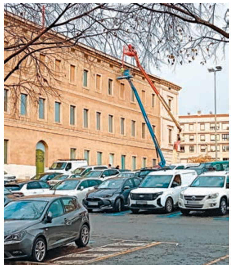
FOTO_ L.M. Operaris sobre una grua posant les reixes
