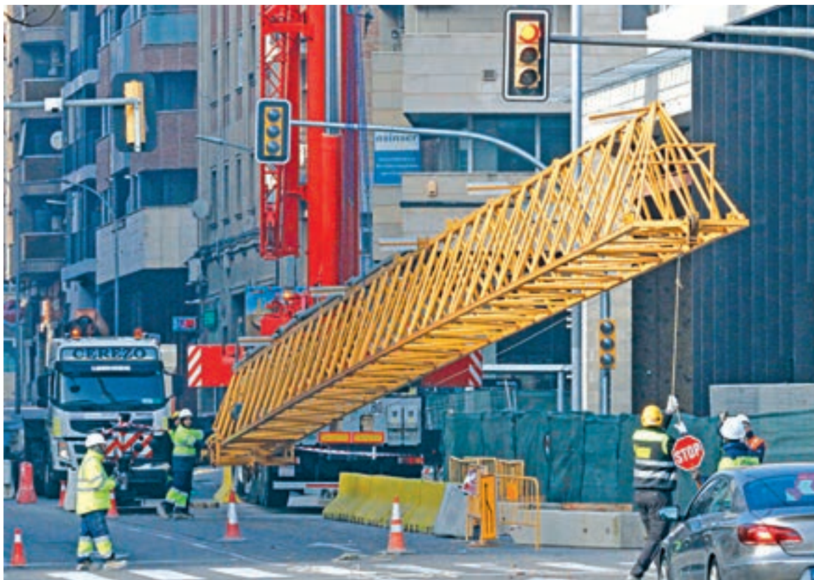
FOTO_ Tony Alcántara Operaris retirant la grua i fent parar el trànsit de vehicles
