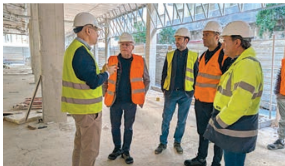
FOTO_ Aj. de Salou Granados observa l'estat actual de les obres
