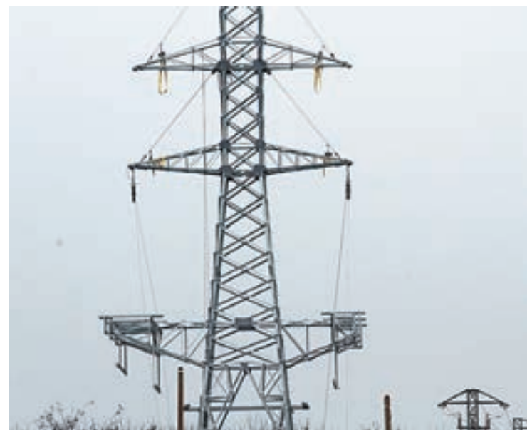
FOTO_ Tony Alcántara Pla detall d'una part d'una de les torres elèctriques que ahir instal·laven a Rufeà
