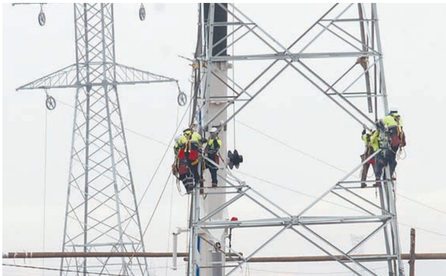
FOTO_ Tony Alcántara Els operaris instal·len una de les torres elèctriques a la partida de Rufeà
