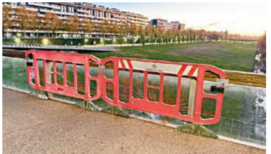
FOTO_ RafaPMedina Tanques per protegir el viaducte
