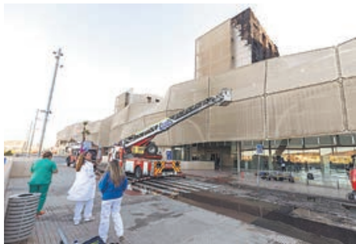
FOTO_ Marcial Guillén (EFE) Sanitaris desallotjats mentre els bombers treballen a l'incendi
