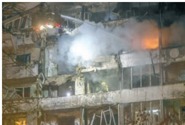
FOTO_ Maxym Marusenko (EFE) Els equips de rescat treballen en un edifici bombardejat ahir per forces russes
