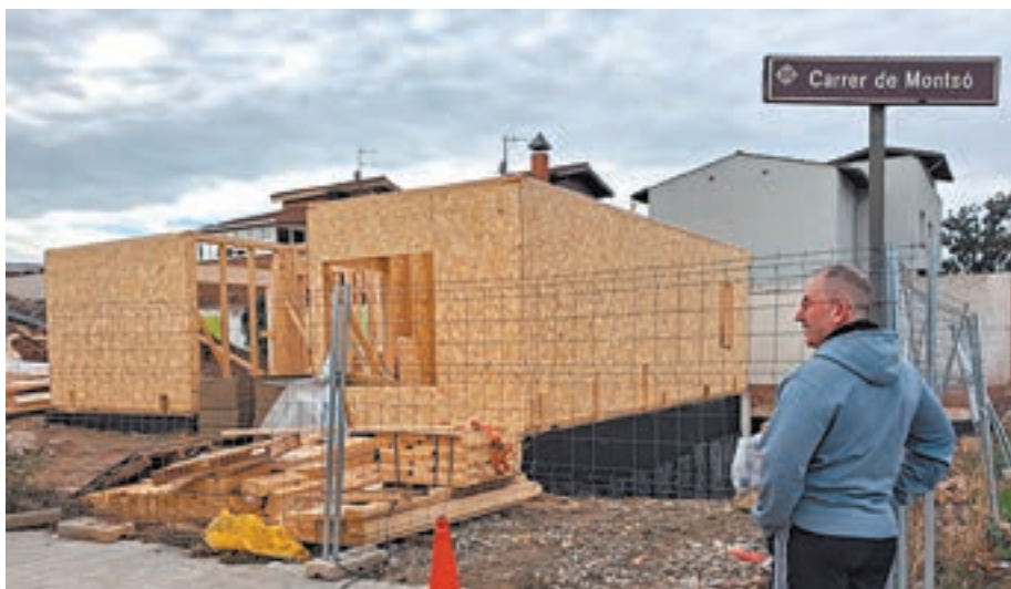
FOTO_ D.A. L'estructura de fusta de l'habitatge és ben visible
