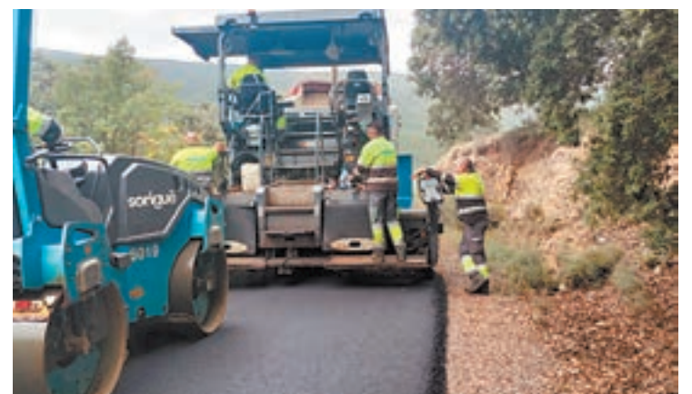
FOTO_ CCPJ Un moment de les obres en un camí
