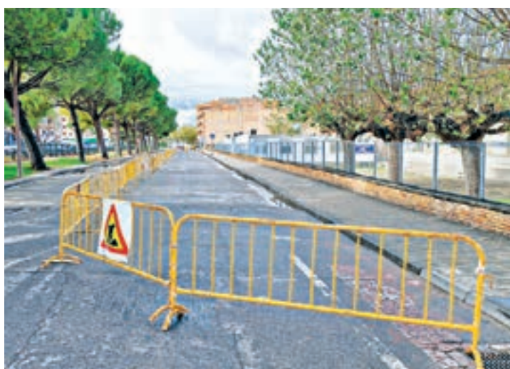
Aj. Mollerussa Les obres es duen a terme a l'Av del Canal
