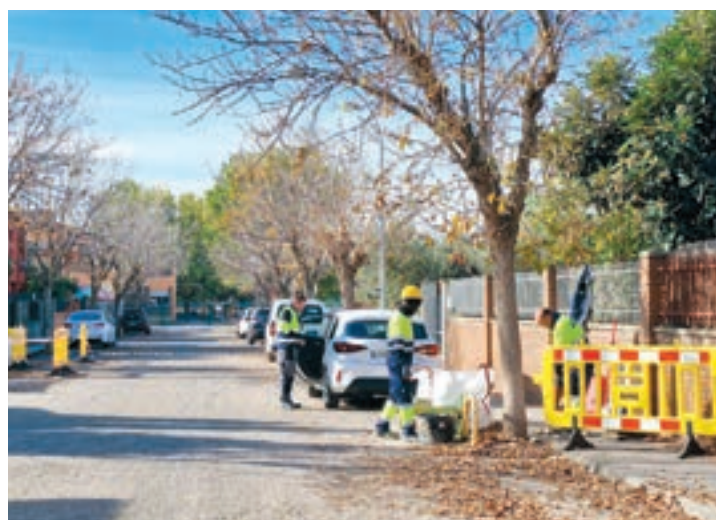
Aj. Mollerussa Obres de renovació al carrer Pau Casals
