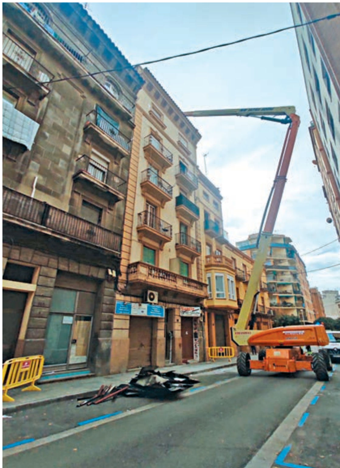
FOTO_L.M. Els treballadors a la grua i algunes de les plaques retirades dels pisos
