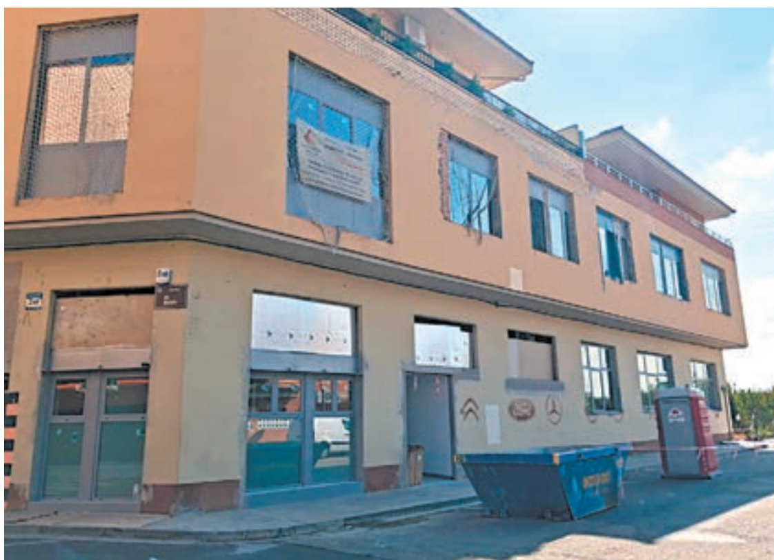
FOTO_ D.A. Estat actual de les obres de l'antic taller Alma, al carrer La Granadella
