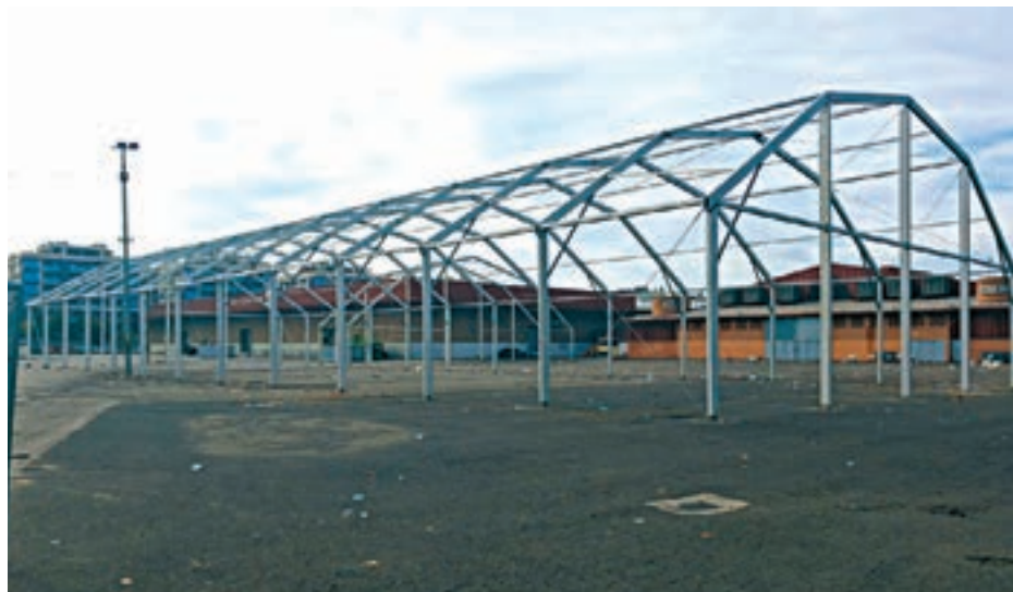
FOTO_ D.A. Imatge de l'esquelet de l'estructura de la gran carpa
