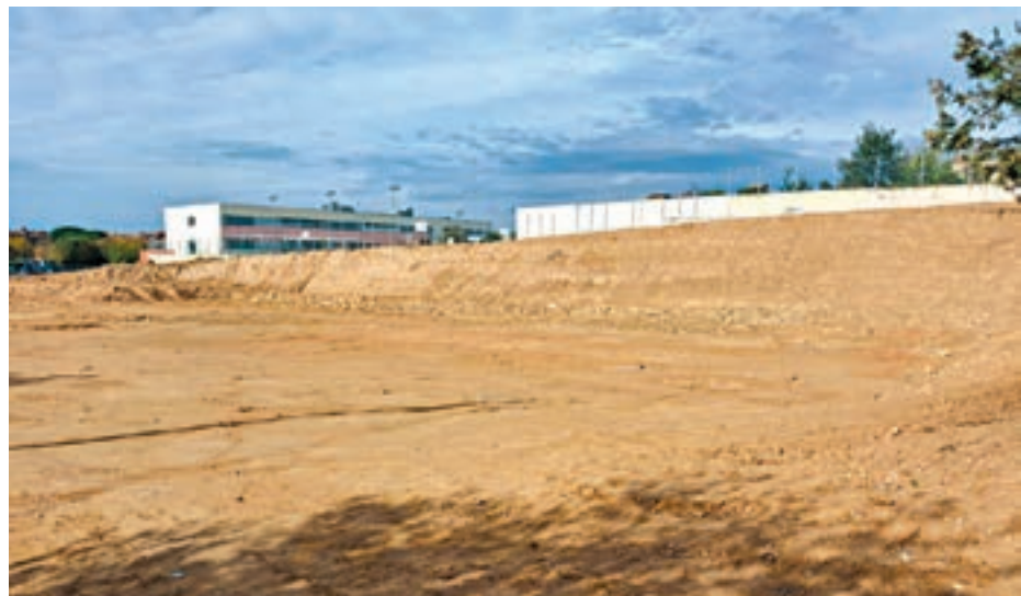
FOTO_ D.A. Durant setmanes s'ha tret el terra d'un tossal de la zona
