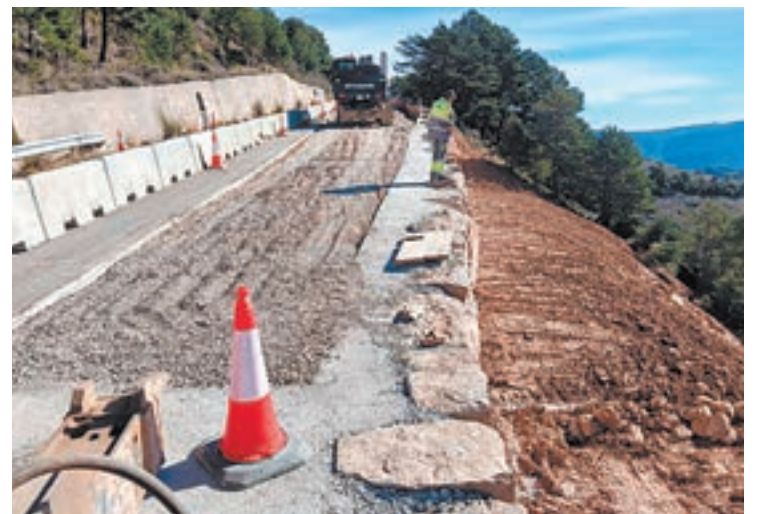
FOTO_ Diputació Treballs en un tram de la via LV-4241
