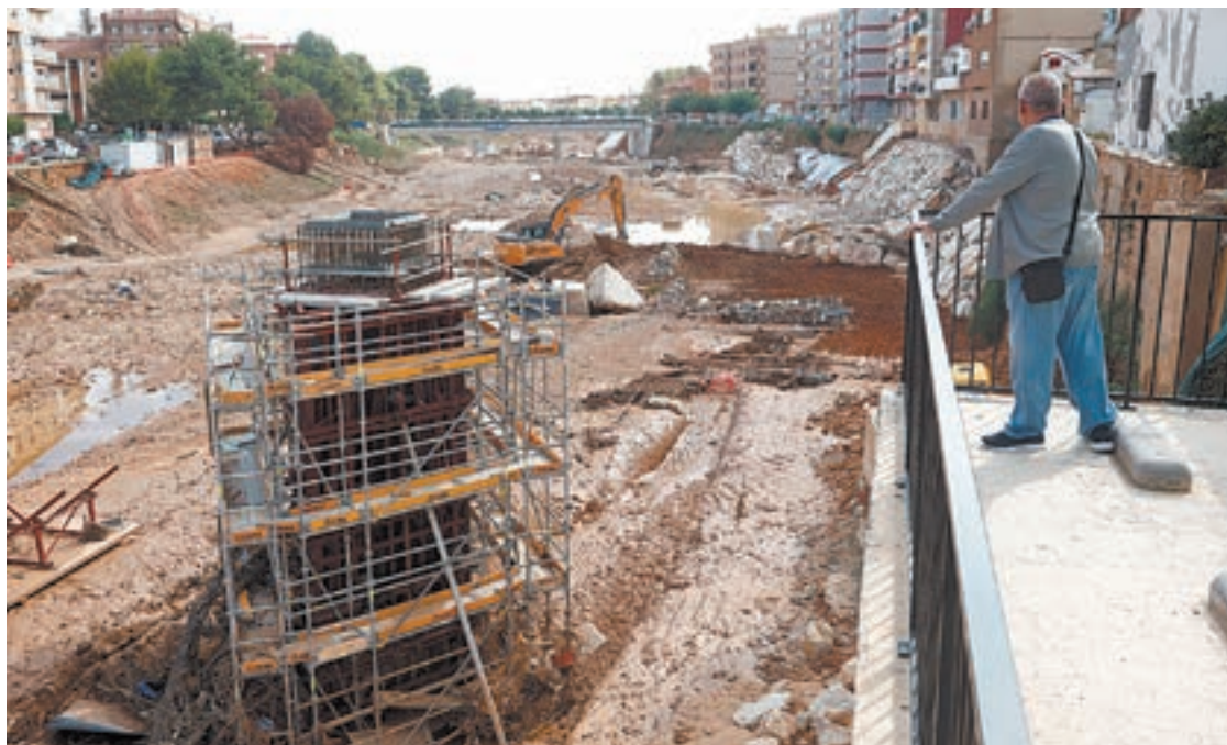
FOTO_ Chema Moya (EFE) Obres de reconstrucció al barranc del Poyo
