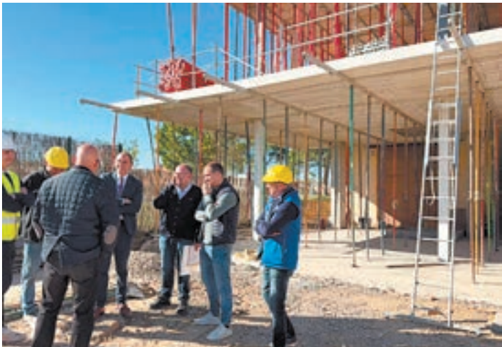
FOTO_ SdG Crespín va visitar ahir les obres
