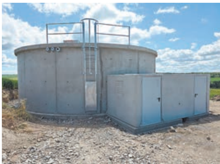
FOTO_ C.C.S. Podrà guardar 300 metres cúbics d'aigua
