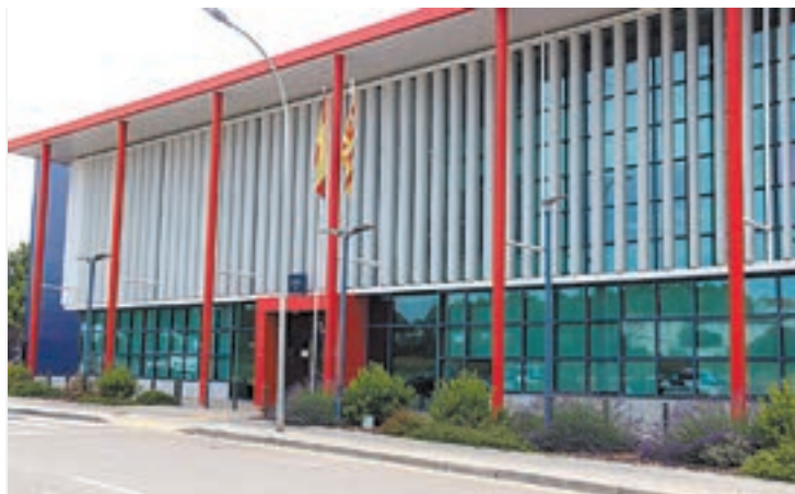
FOTO_ L.M. Edifici de la Comissaria dels Mossos d'Esquadra de Lleida situada al carrer de Sant Hilari
