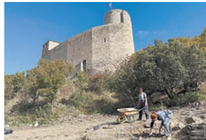
FOTO_ ACN Imatge de les excavacions
