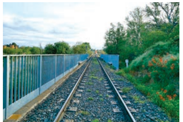
FOTO_ FGC Un punt del tram de via on s'actuarà
