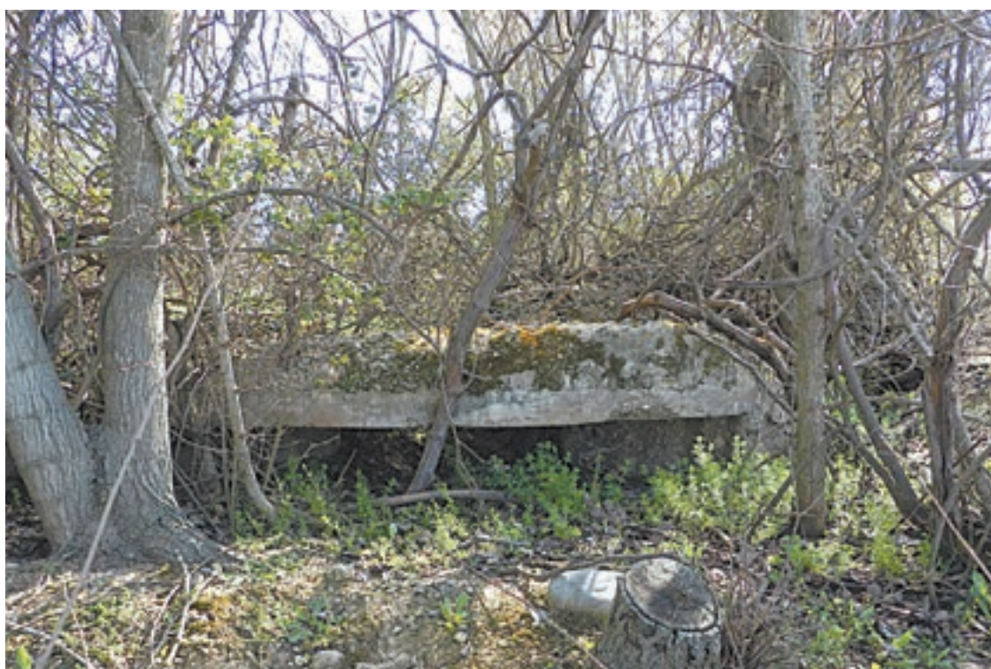
FOTO_D. A. Les obres delimitaran els nius de metralladora com aquest
