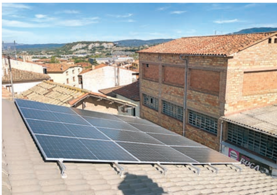
FOTO_ Toni Jáimez (ACN) Plaques solars instal·lades en un habitatge
