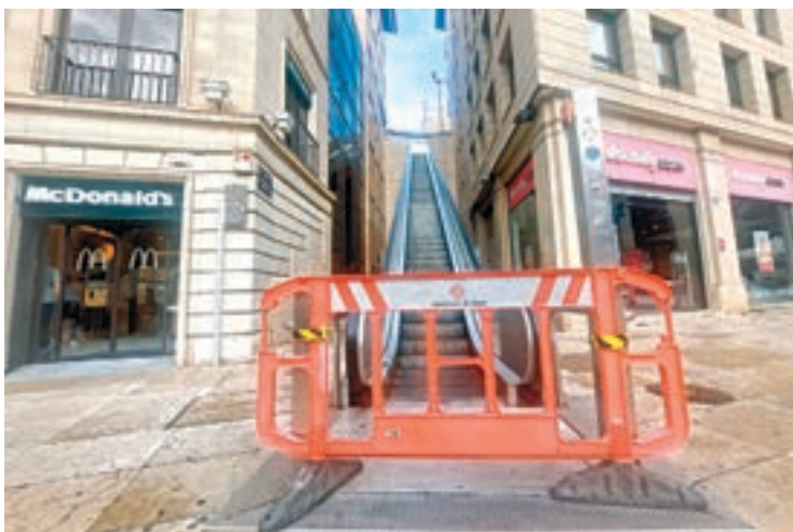
FOTO_ Tony Alcántara Les escales automàtiques i l'ascensor d'accés al Canyeret estan espatllats
